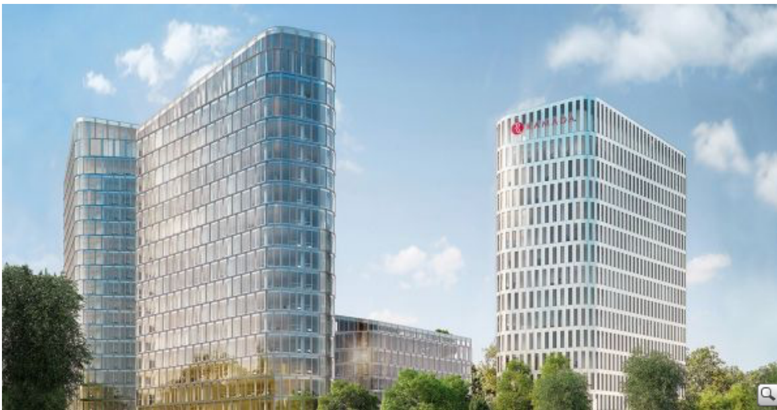
Referenz: BAVARIA TOWERS München, ca. 8.500 m 2 Betonkerntemperierung 2017
