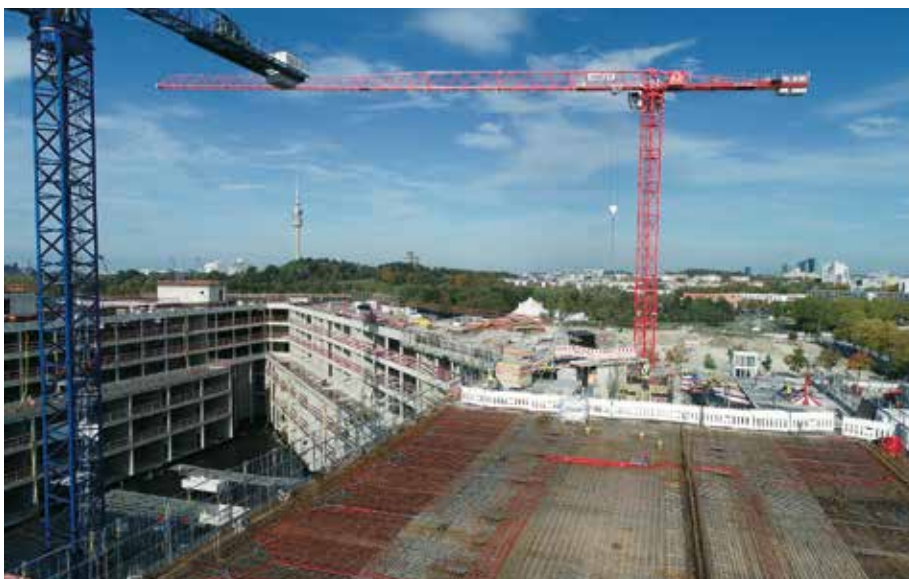
Drohnenbild vom Neubau des Straßjustizentrums München. Realisiert wurde eine Betonkernaktivierung.
